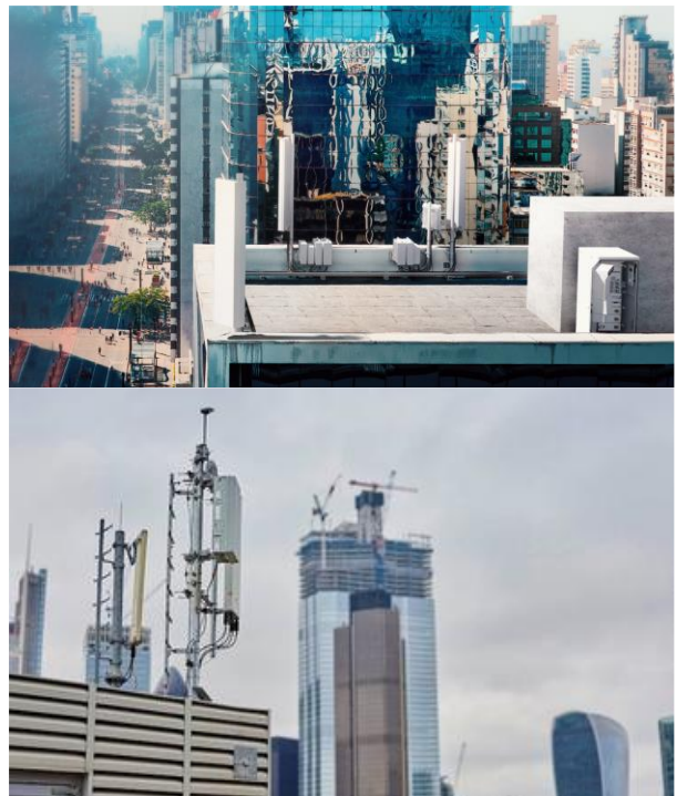
그림12. 도심 지역의 Rooftop Cell Site
