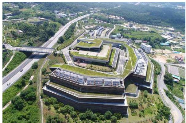
그림45 네이버 춘천 데이터센터 ‘각’ 전경
