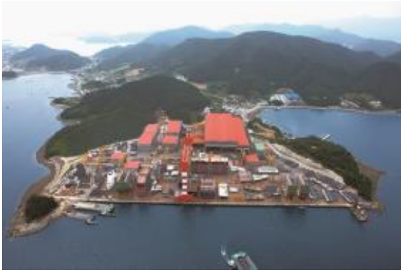
도표 80 삼강엠피엔티 공장
