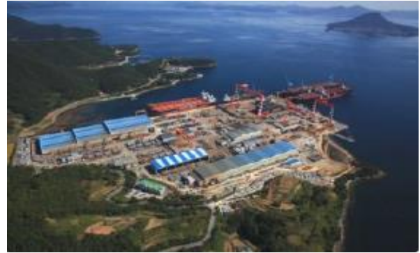
도표 54 삼강엠엔티 공장(삼강 S&amp;C)
