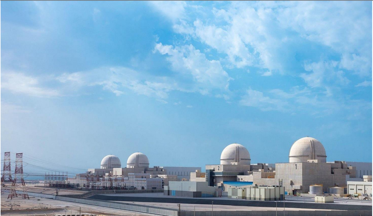
그림25.UAE 바라카 원전 1~4 호기 전경
