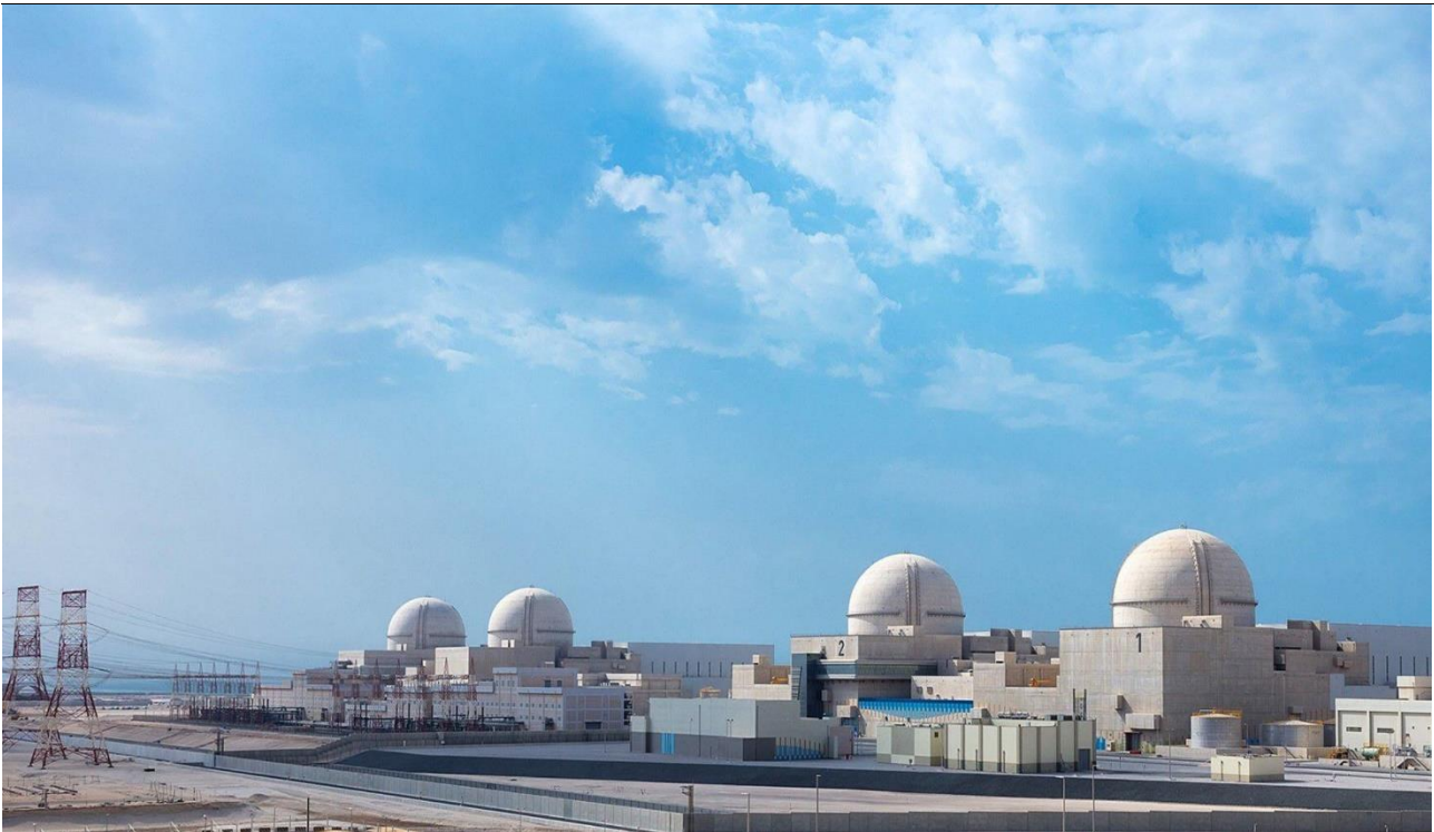
그림13.UAE 바라카 원전 1~4호기 전경
