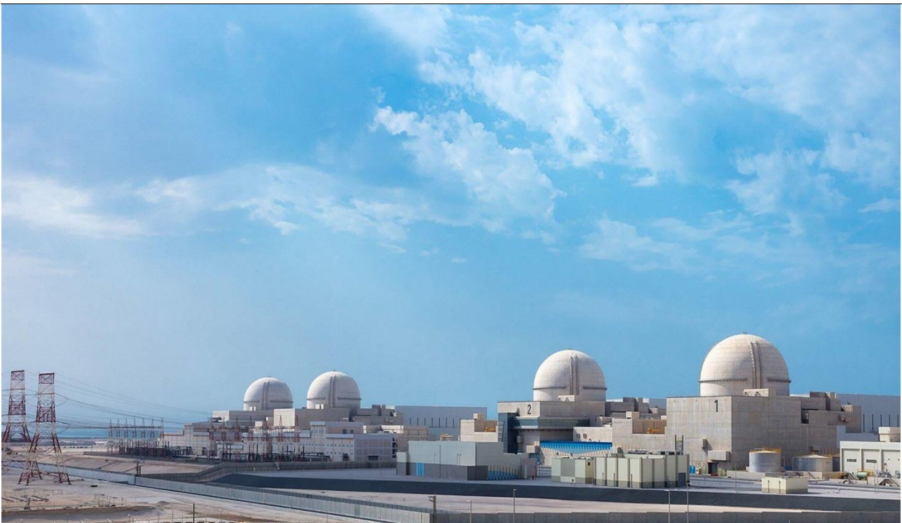
그림16. UAE 바라카 원전 1~4호기 전경
