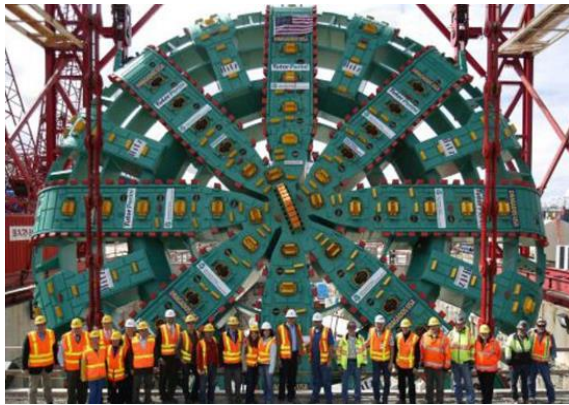
그림 20. 최대 규모의 TBM, 버사(직경 17.5m의 260개의 커터)
