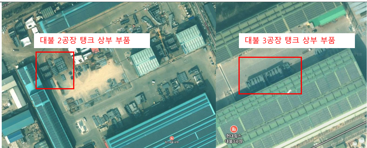
그림 14. 현대hips(HD현대삼호) 대불 2,3 공장 위성 지도: 올해부터 대불 4공장에서 탱크 하부~보온 공정까지 포함하여 연 3.5척의 탱크 제작 예정
