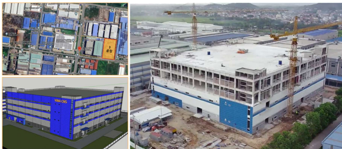
도표 19. 3 공장 건축현장 (공정률 87% 진행 중)
