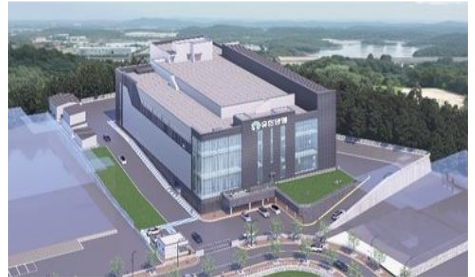
경구용 고형제 공장 신축
