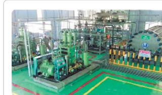
스택을 도입하여 당사가 BOP 1 구성 후 설치·시운전
