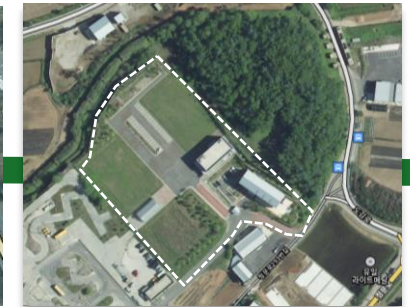
[파주에코파크1,2 (19MW)] '24년 HPS 낙찰 사업
