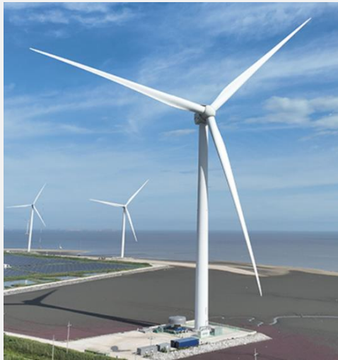
* 당사 10MW 풍력 터빈 적용된 영광 실증지 전경
