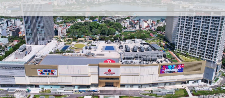
베트남 롯데몰 웨스트레이크 하노이 쇼핑몰
