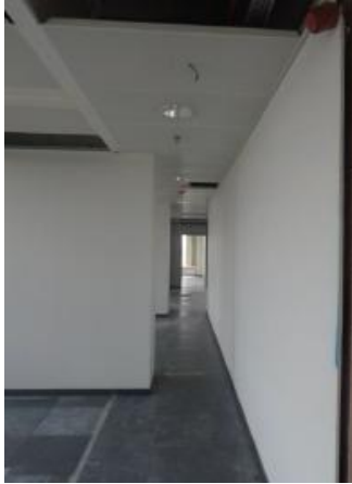
공간 재구성 공사
