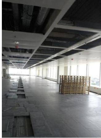
고속 광케이블 설치
