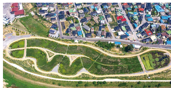
영천동 비점오염저감시설 (제천시 청풍호로 8길 7/구간 527m)
