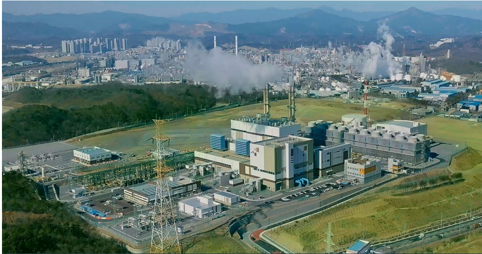
LNG - LPG Dual Fuel 발전 : 울산지피에스
