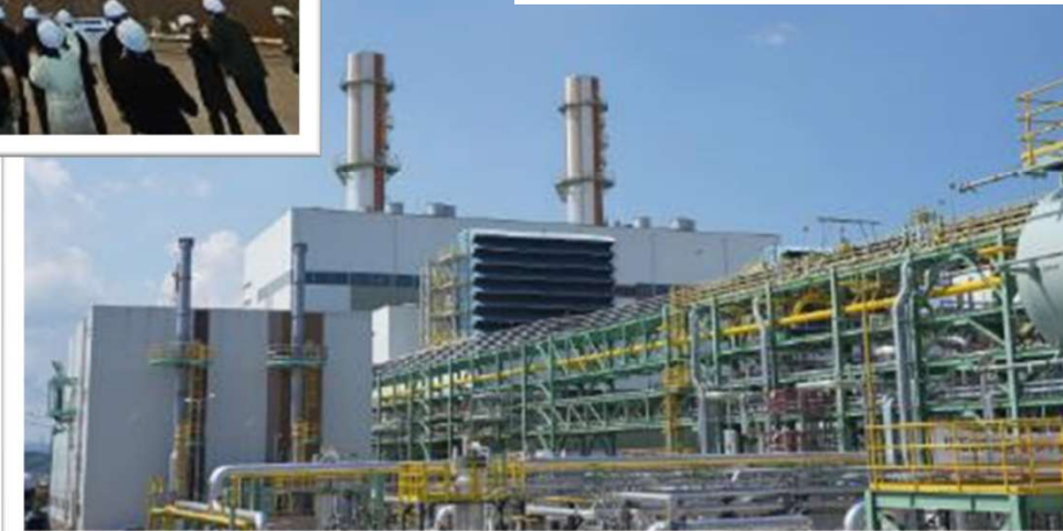
[사진 3 : 울산지피에스 현장]
