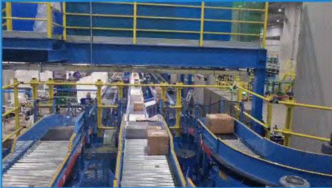
물류 센터 Conveyor
