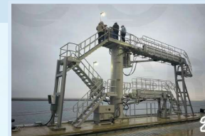
상부 설비 설치
