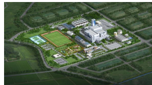
함안복합 (EPC 공사)
