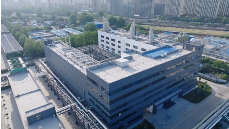
사진설명 1 : 신축 툴라스로마이신 원료 공장
