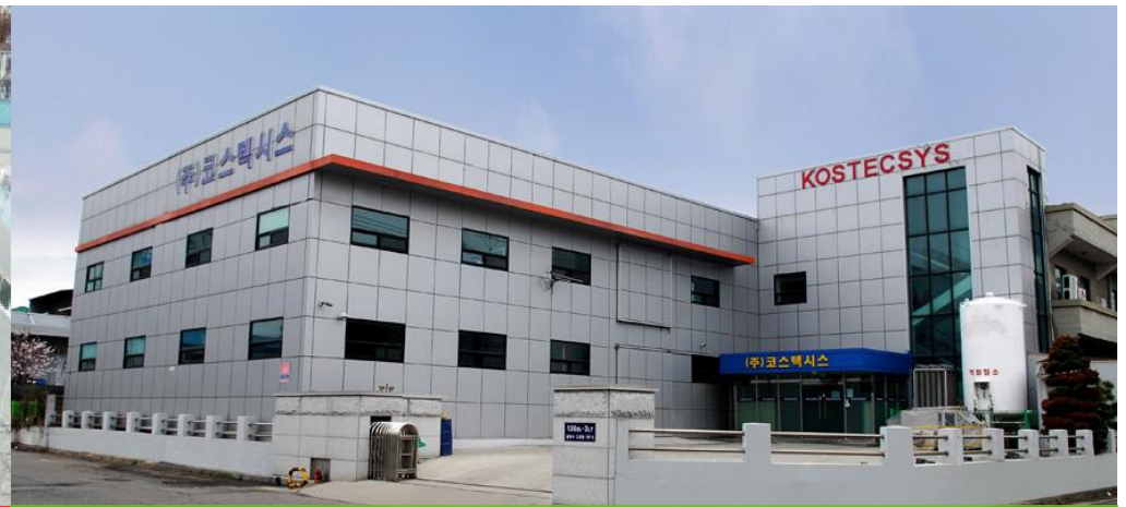
2공장(신규 시설 투자 진행중) 인천광역시 남동구 능허대로 625번길 43 (남동공단 136B-3L) 대지(1,491m 2 )/건평(2,250m 2 )
