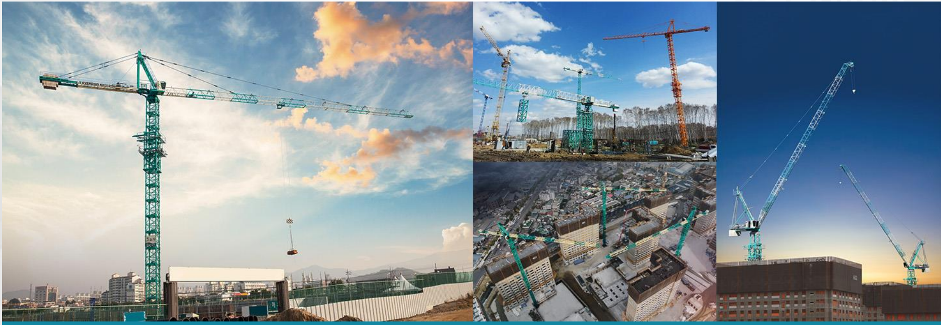
Tower Crane 타워크레인
