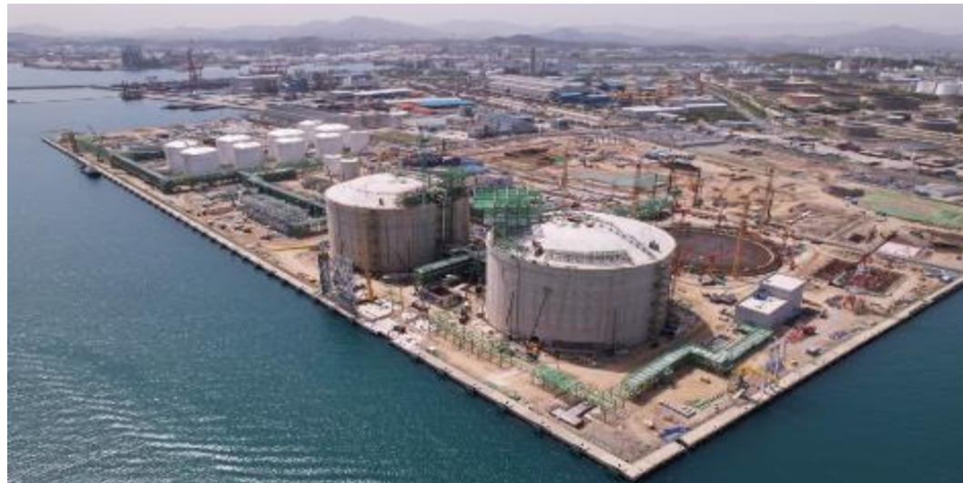
[ 코리아에너지터미널(KET) - 공정률 78.7% (LNG Tank 1,2) ]
