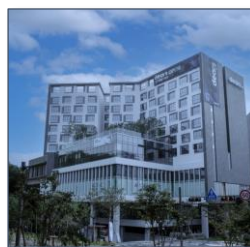
디어스 판교 (521세대) 기업형임대주택 / '21.4월 준공 (이지스200호)
