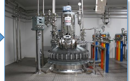
Crystallizaion Reactor (결정화 반응기)
