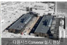
다원시스 Converter 설치 현장
