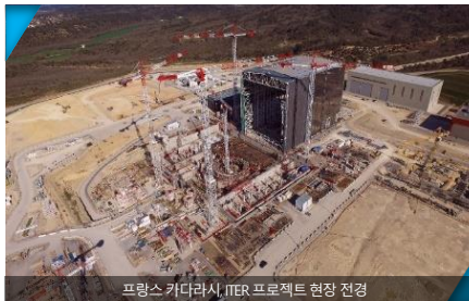
프랑스 카다라시 ITER 프로젝트 현장 전경
