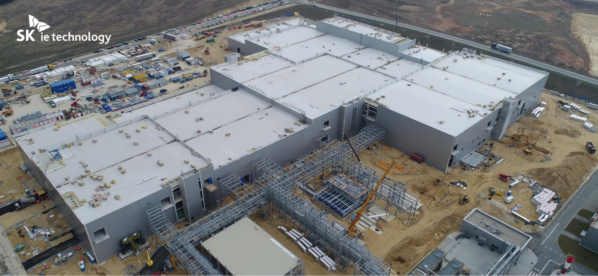
SK hi-tech battery materials Poland sp. z o.o.(폴란드 법인) Phase 2 증설 현장
