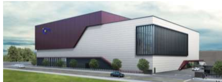
화장품 1공장 (완주)
