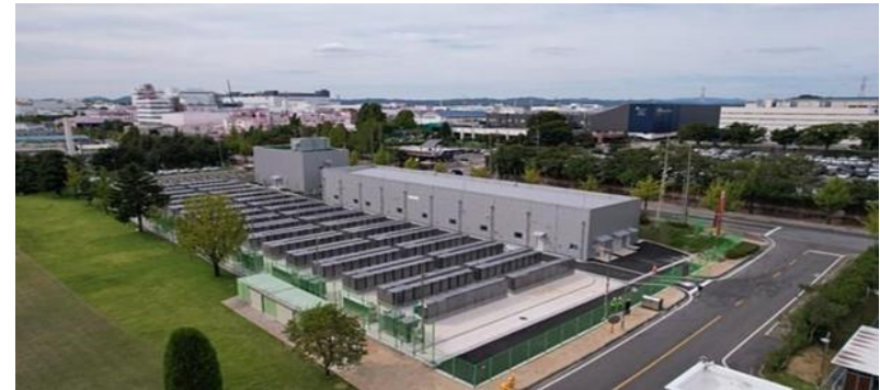
■ 청주에코파크 연료전지 발전소 전경
